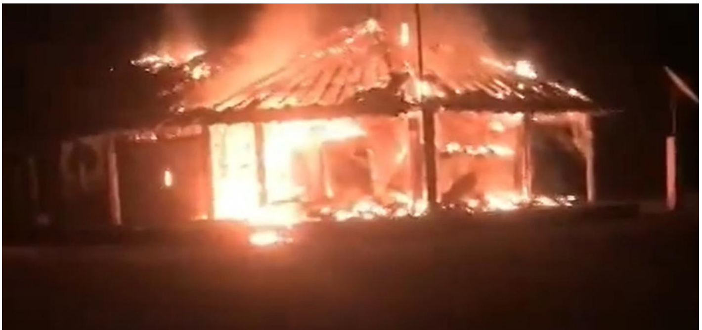
Figura 06: Incêndio na Oca Parque Lage, RJ, 2021.
