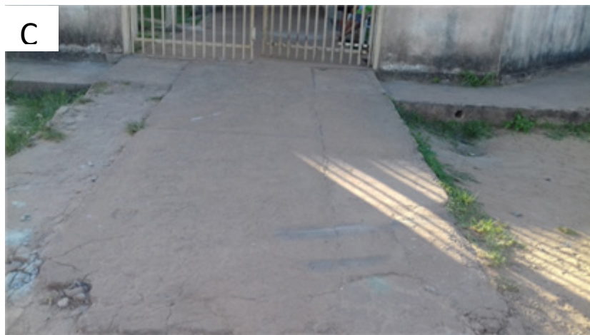
Figura 02. : Rampa da entrada da Escola pesquisada.
