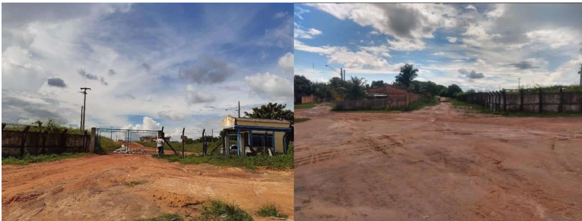
Figura 6- acesso para lagoa de estabilização
