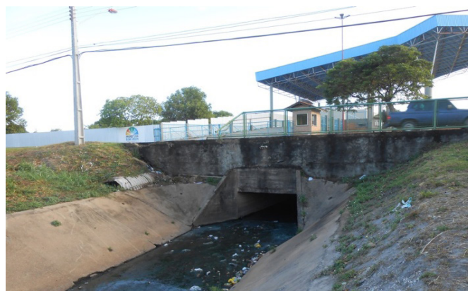
Figura 2: Canalização do Igarapé Mecejana (trecho 6)
