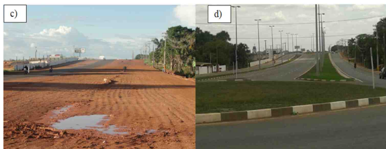
Figura 5: c) início da duplicação da BR-174, 2012 d) conclusão da duplicação da BR-174, 2014.
