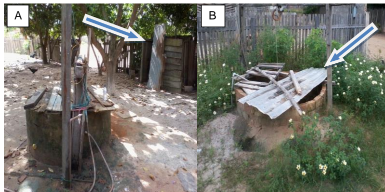
Figura 3 - Tampa inapropriada do poço M6 e situado próximo ao sanitário (A); Poço M4 Tampa inadequada, praticamente aberto.
