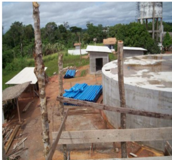
Figura 4: a) Tratamento atual de água em Rorainópolis – Processo de cloração. b) Instalações da futura ETA de Rorainópolis (obra inacabada).
