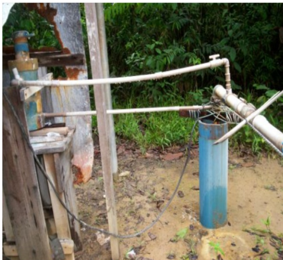
Figura 4: a) Tratamento atual de água em Rorainópolis – Processo de cloração. b) Instalações da futura ETA de Rorainópolis (obra inacabada).
